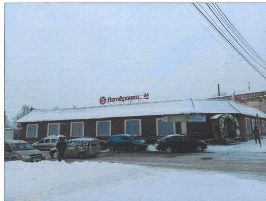
Главный фасад по ул. Смирнова
